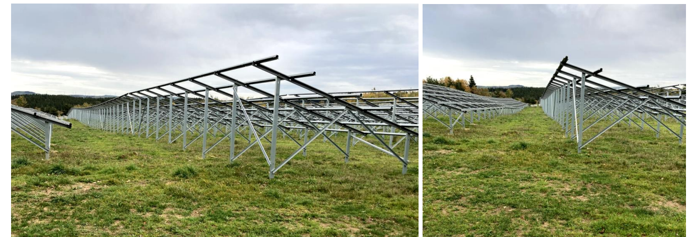
Photo 12 : Exemple de chantier photovoltaïque avec maintien de la couverture herbacée
