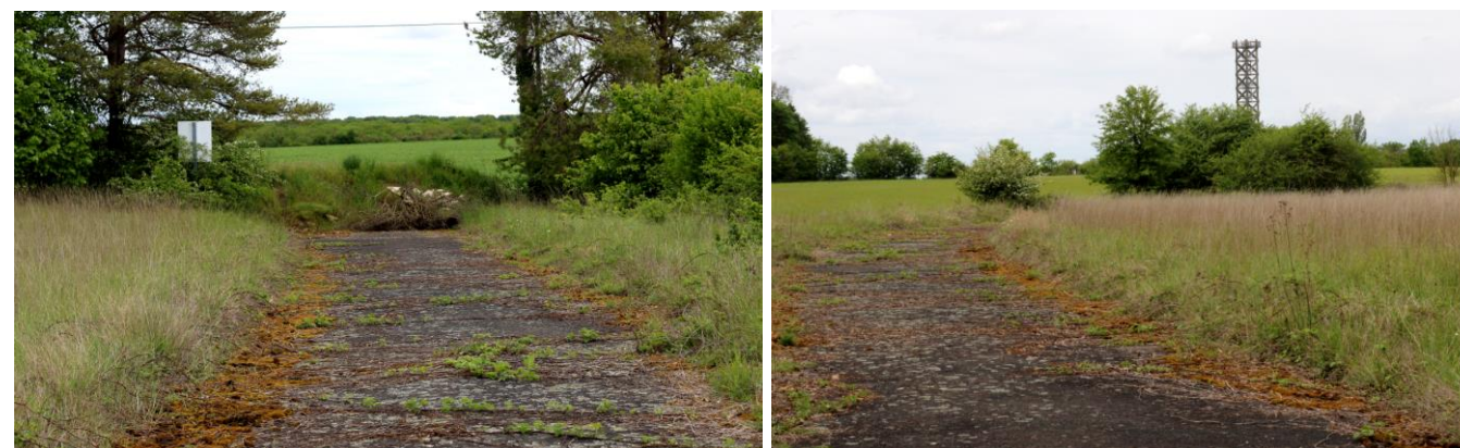
Photo 13 : La route existante, réutilisée pour l'accès à la centrale, est déjà constituée d'un revêtement bitumineux.
